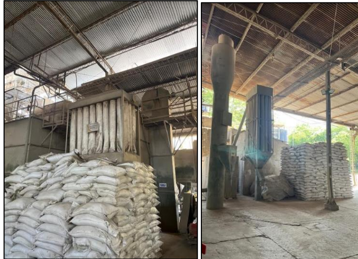
Figura 7. Filtros de manga. Planta de beneficio fosfatos del huila
