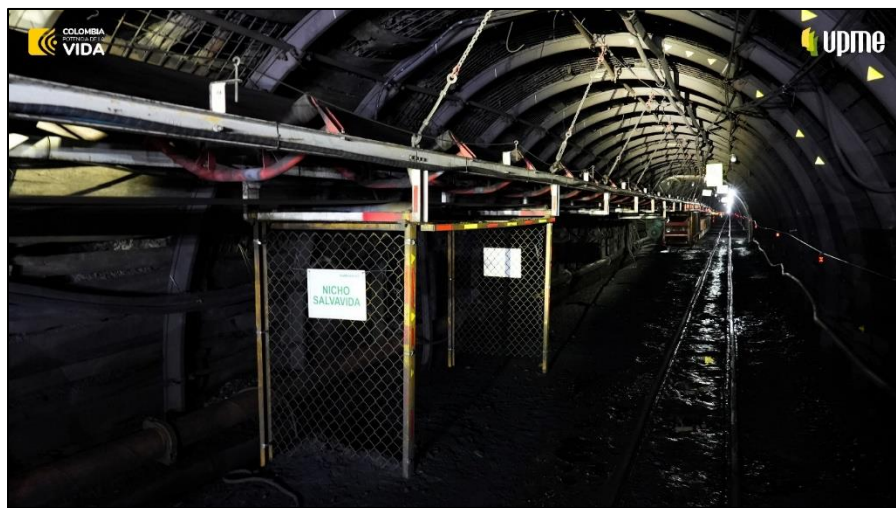
Figura 1. Vista general del túnel Casablanca. Se evidencian los arcos de acero y la banda transportadora
