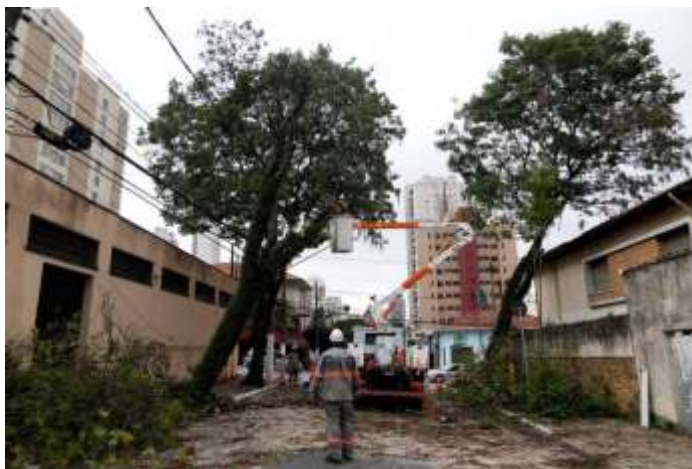
Ilustración 14: Arreglo de daños São Paulo 2024
