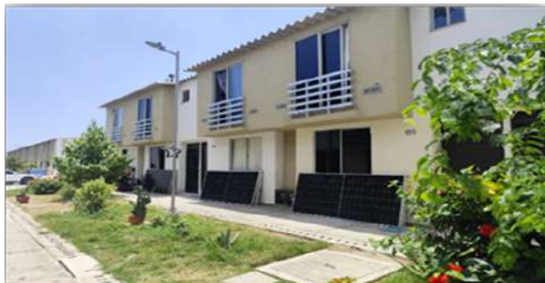
Imagen 10. Proyecto piloto Villas de San Pablo, Barranquilla
