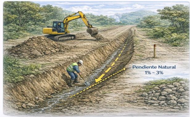
Figura 3.26. Cómo es la excavación de cuneta siguiendo pendiente natural
