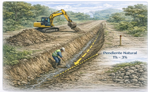
Figura 4.26. Cómo es la excavación de cuneta siguiendo pendiente natural
